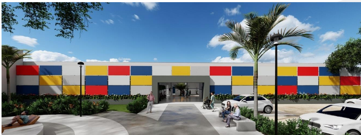
Imagem 03: Fachada com placas cimentícias
